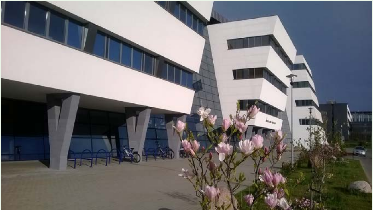
Fot. 5 i 6. Obecna siedziba Wydziału Biologii na terenie Bałtyckiego Kampusu Oliwa (Gdańsk, ul. Wita Stwosza 59). Fot. A. Borman, P. Rutkowski
