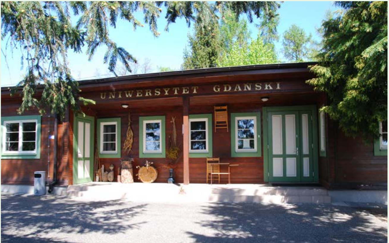
Budynek Stacji. Fot. A. Sadowska
