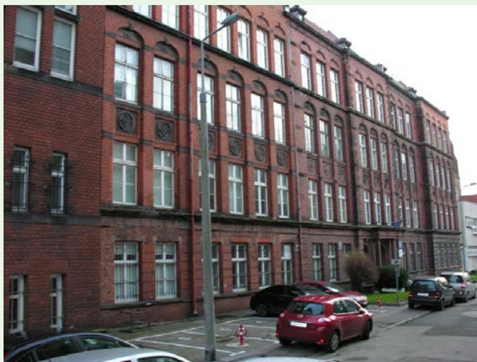
Fot.2. Budynek przy ul. Kładki 24 w Gdańsku (dawniej Victoriaschule). Fot. T. Kretowicz
